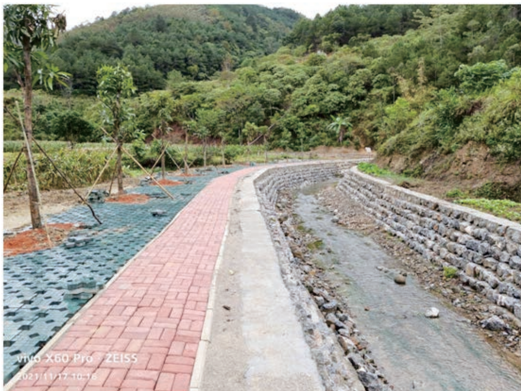
图 2-2 德保县知屯生态清洁型小流域水土保持综合治理工程
