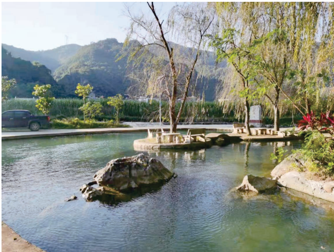
图2-3 右江区泮水乡百维生态清洁型小流域水土保持综合治理工程
