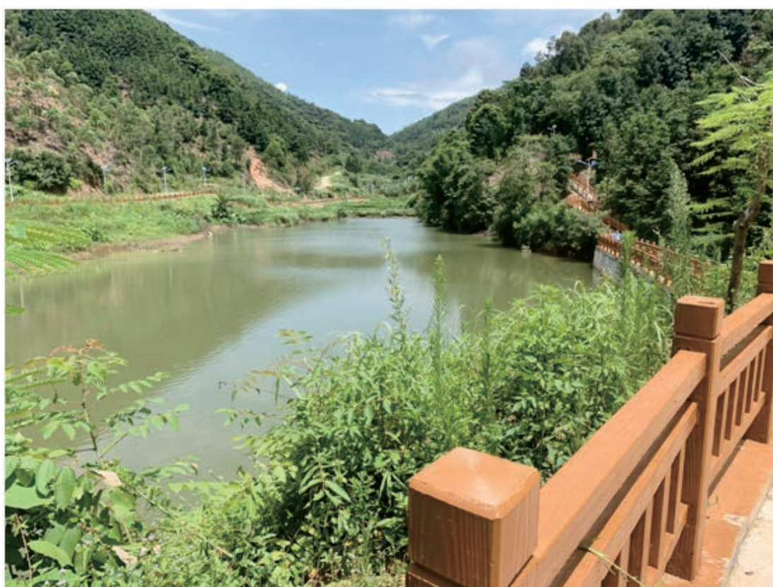
图2-4 博白县圣女岭生态清洁小流域水土保持综合治理工程
