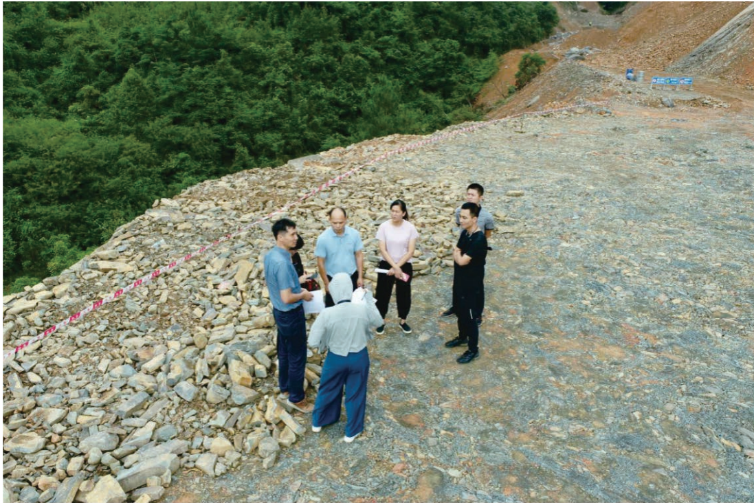
图 3-4 现场检查S307田阳坡洪至那坡坡荷公路（德保段）工程
