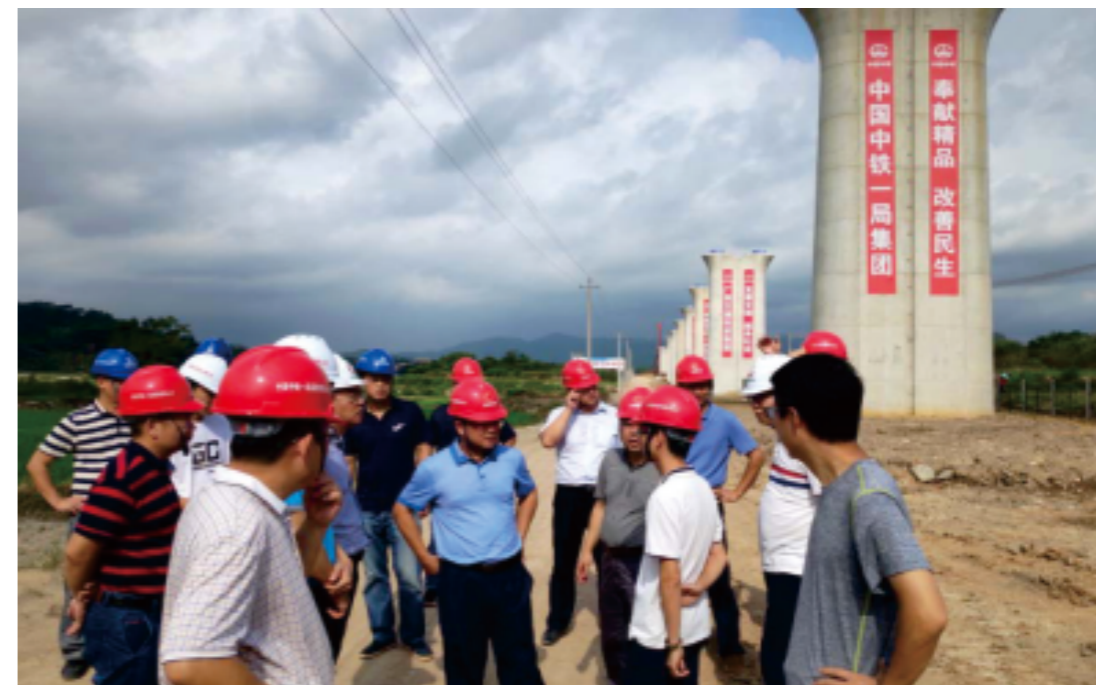
现场检查新建南宁至玉林铁路工程
