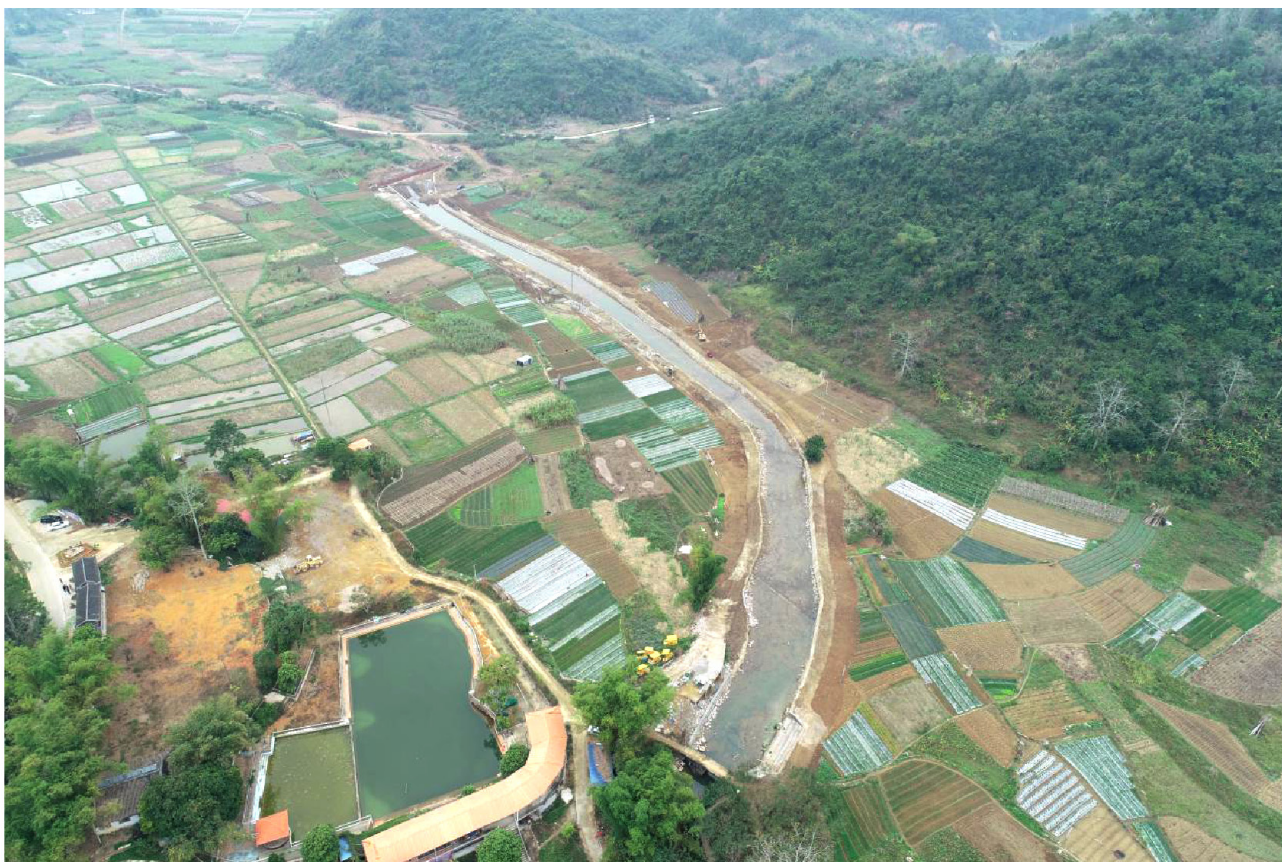
龙州县小湾河生态清洁型小流域护岸工程
