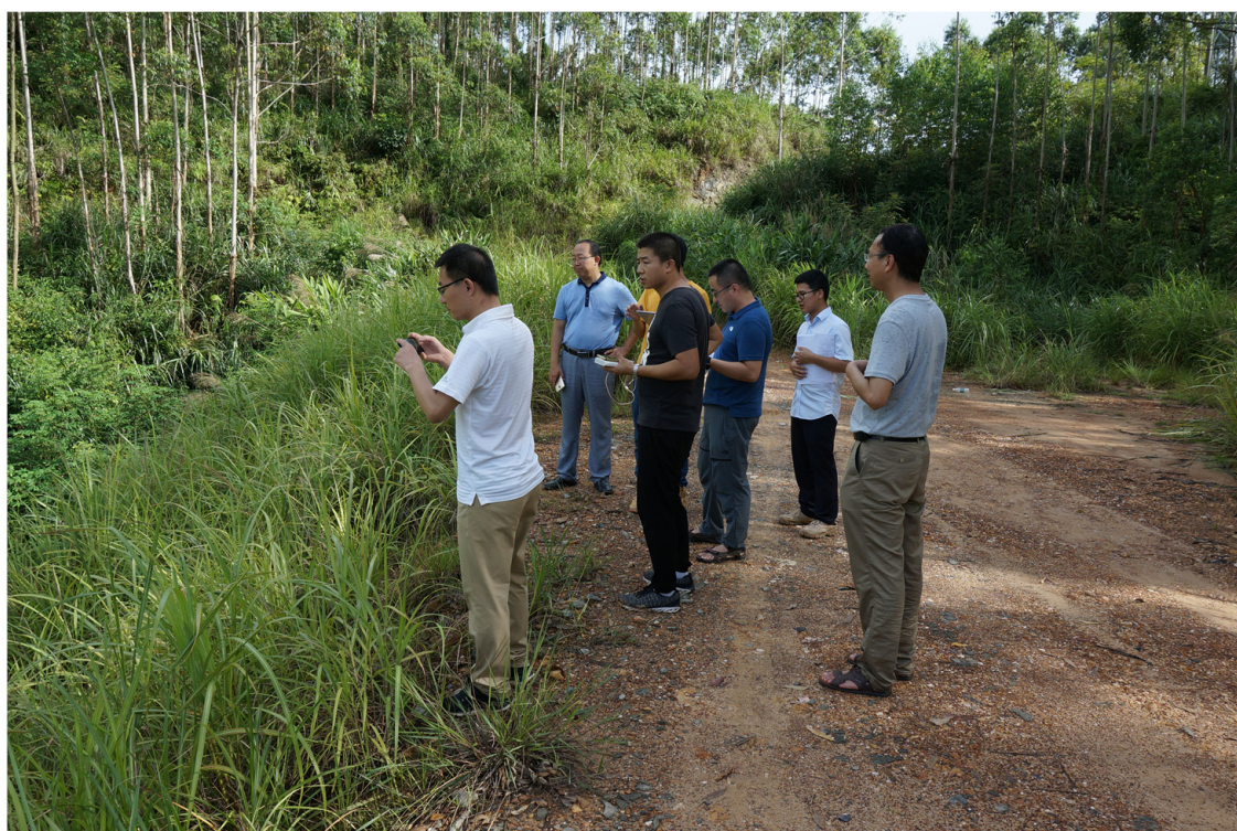
广西滨海公路龙门大桥西引道工程自主验收核查
