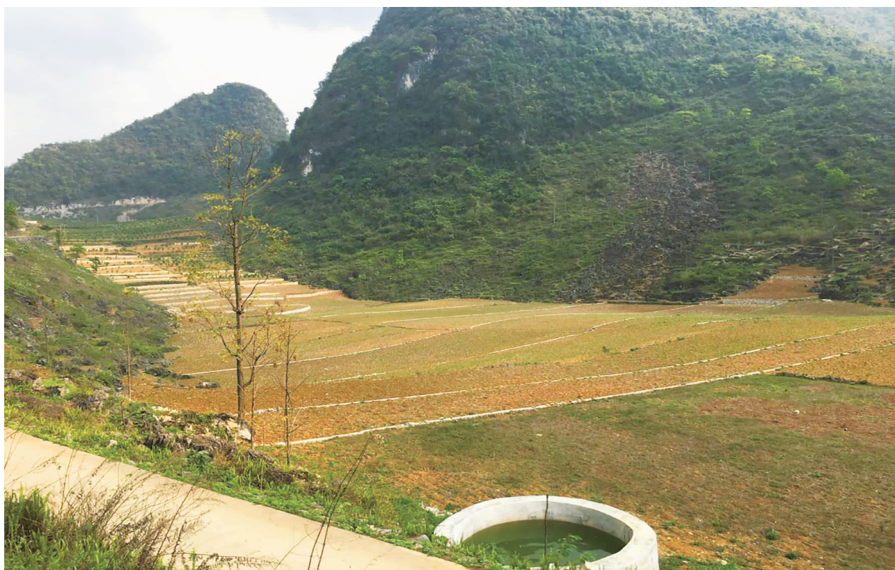
那坡县弄旺小流域水土保持综合治理工程
