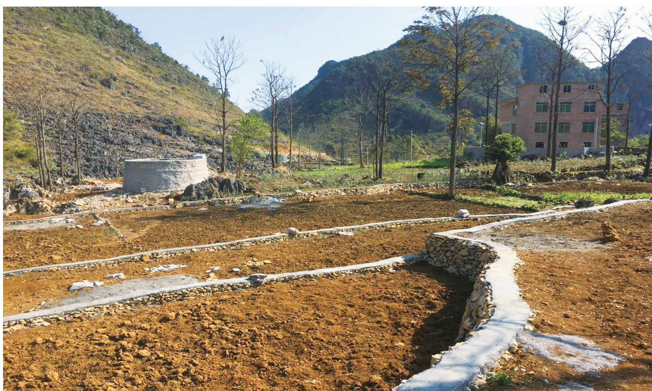
那坡县洞汉小流域水土保持综合治理工程
