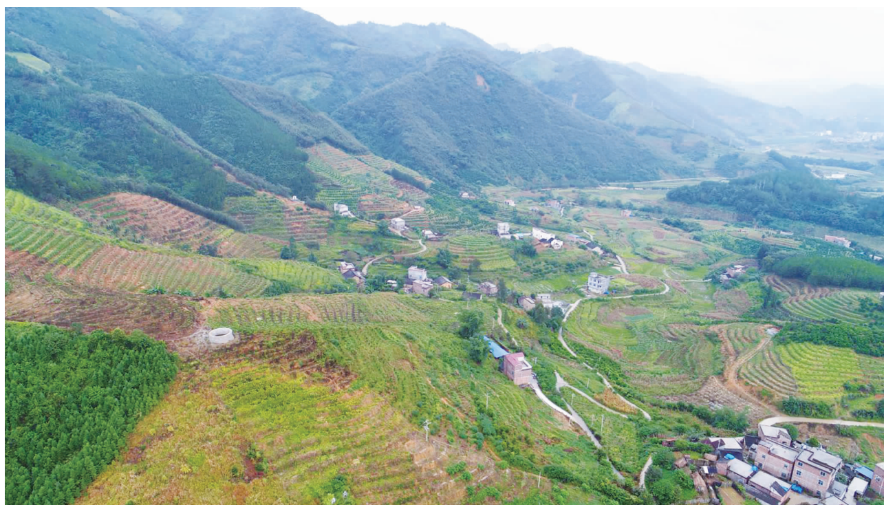
西林县坡耕地治理工程
