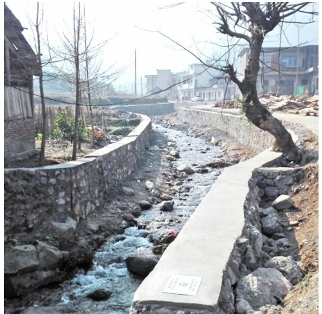
灌阳县秀江项目区正江小流域治理工程
