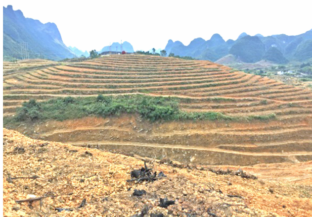
罗城县坡耕地水土保持综合治理工程
